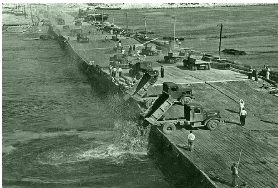
Строительство Каховской ГЭС. Фото с сайта http://otdoohnul.ru/ukraine/kahovskaya-ges/
